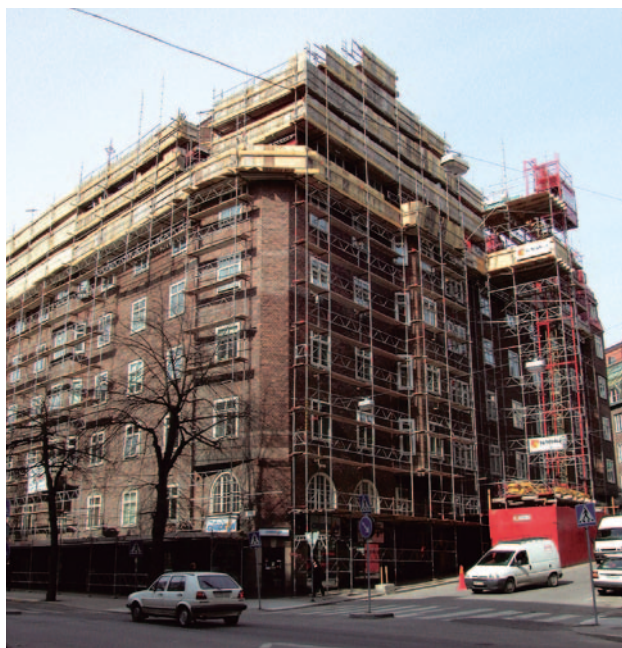
Asken 16, Eriksbergsgatan 1 A–B samt Briger Jarlgatan 40, Stockholm. FPK bygger ett antal vindsvåningar om ca 150 m 2 styck, vilket ytterligare kommer att stärka fastighetens värde.
